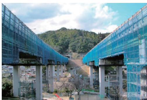
インバイロワン工法後にブラスト処理での素地調整を行わない施工現場では、粉じん対策用の設備が省略できる場合があります。
